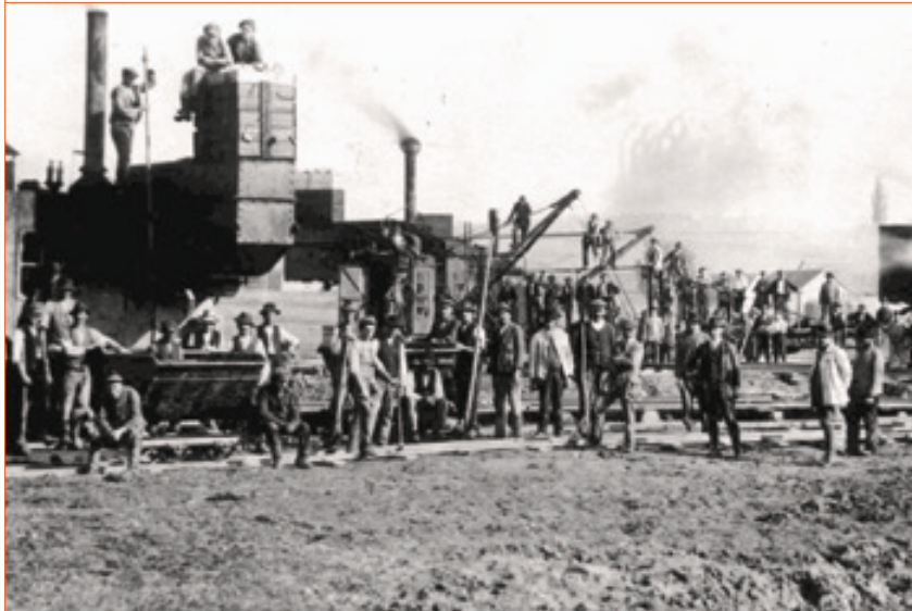
Notstandsarbeiten im Landkreis Dachau, hier Glonnregulierung bei Jedenhofen, bei der auch Arbeitslose aus Dachau und München eingesetzt wurden (1920–1923) Quelle: Sammlung Größ, Vierkirchen Foto: Thomas Angermeier
