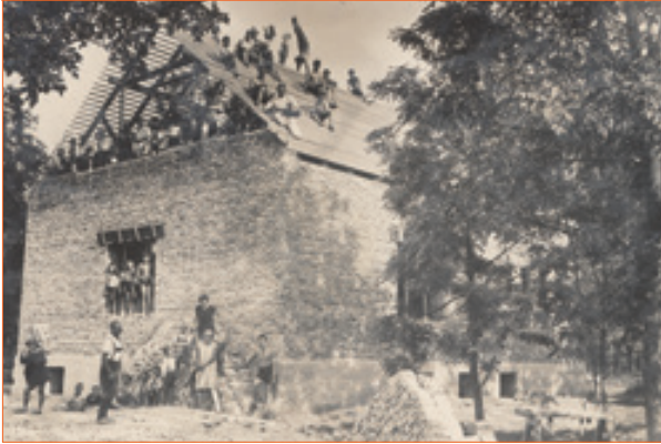
Mitglieder des Sportvereins beim Bau des ersten Vereinsheims, das zwischen 1928 und 1931 aus Abbruchmaterial der Pulver- und Munitionsfabrik entstand (ca. 1930) Quelle: ASV Archiv
