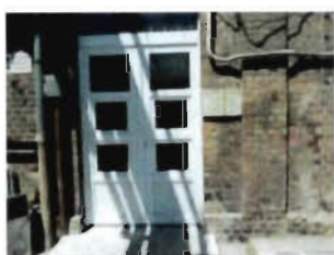
Eingang zum Bródy's Arbeitsbereich
